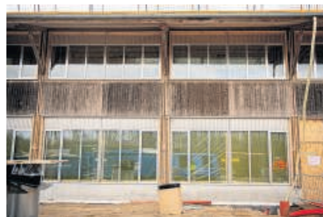
Facaden på det nye hus er blevet genbrugt. Da lageret i sin tid blev bygget, insisterede Lars Kann-Rasmussen på, at facaden skulle beklædes med ubehandlet fyr. Der var ingen der troede på, at det ville holde, men snart 30 år efter står det stadig. Foto: Morten Pape
