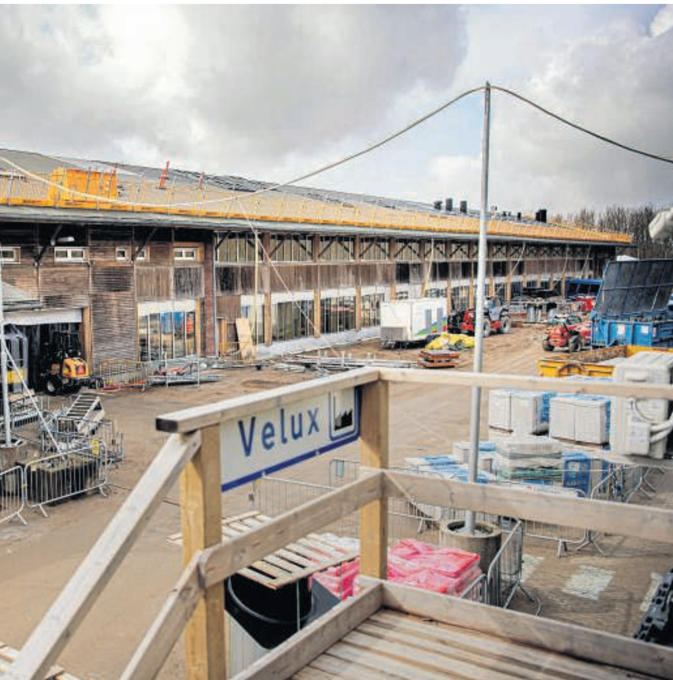
Over 150 håndværker har sin daglige gang på den store byggeplads. Foto: Morten Pape
