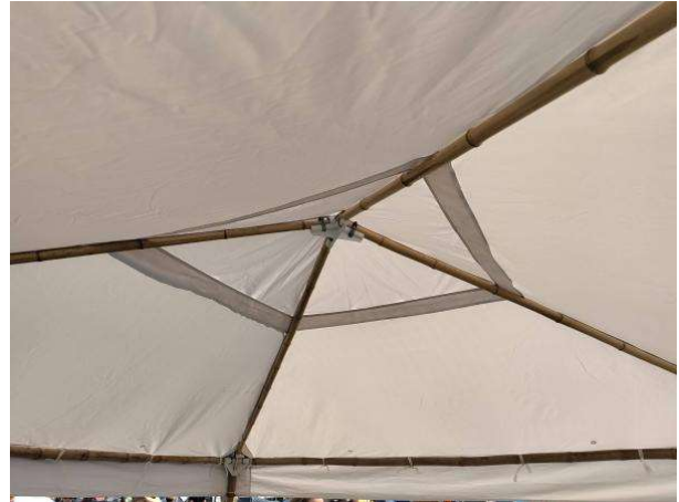
I toppen af pavillonen er der gjort plads til, at vinden kan trænge igennem. Alle sammenføjninger er desuden 3D-printet. (Illustration: Benjamin Bøllehuus)
