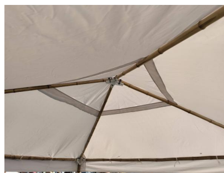
I toppen af pavillonen er der gjort plads til, at vinden kan trænge igennem. Alle sammenføjninger er desuden 3D-printet. (Illustration: Benjamin Bøllehuus)
